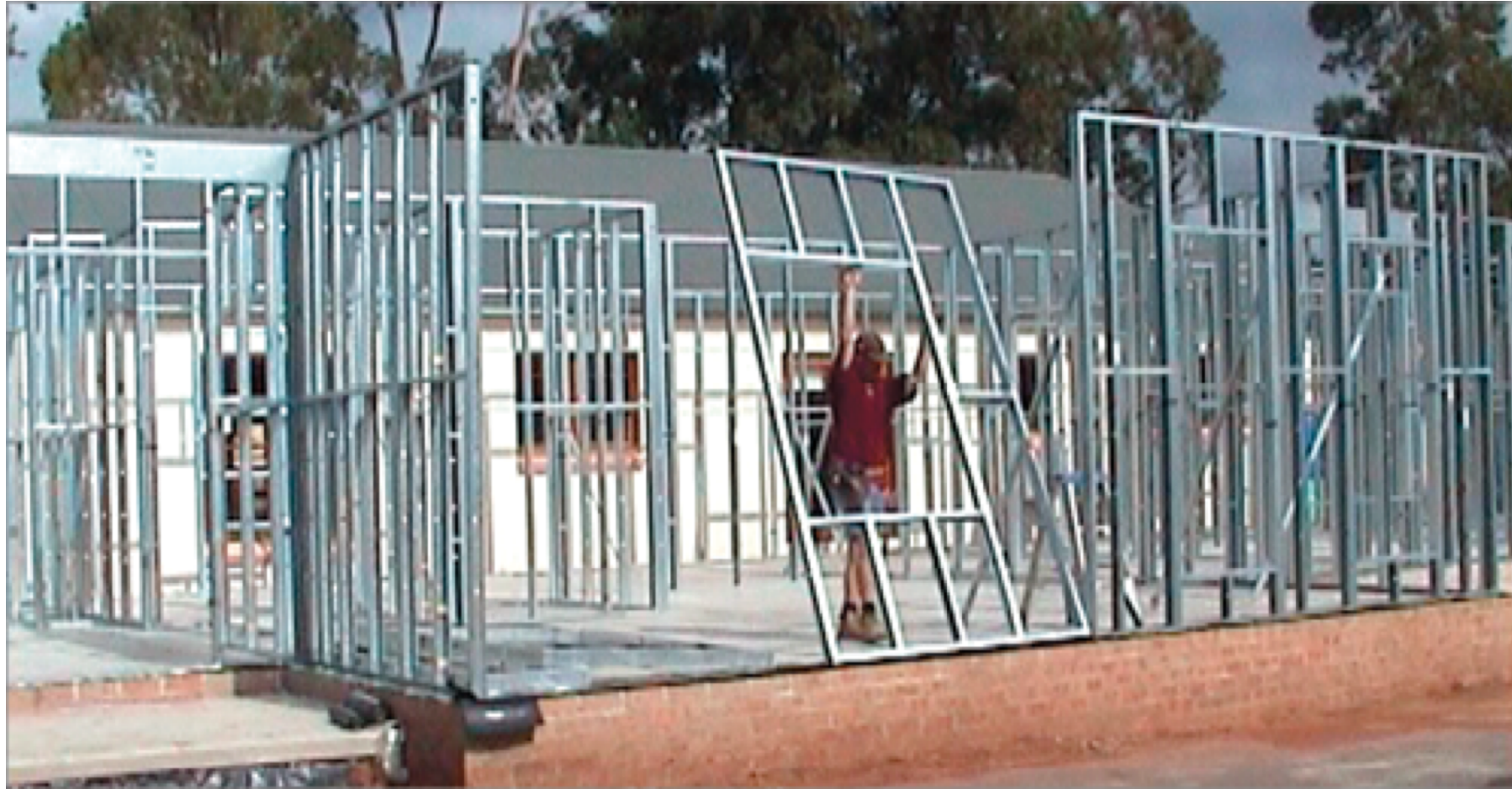
SISTEMAS LIGERO DE ESTRUCTURA DE ACERO
