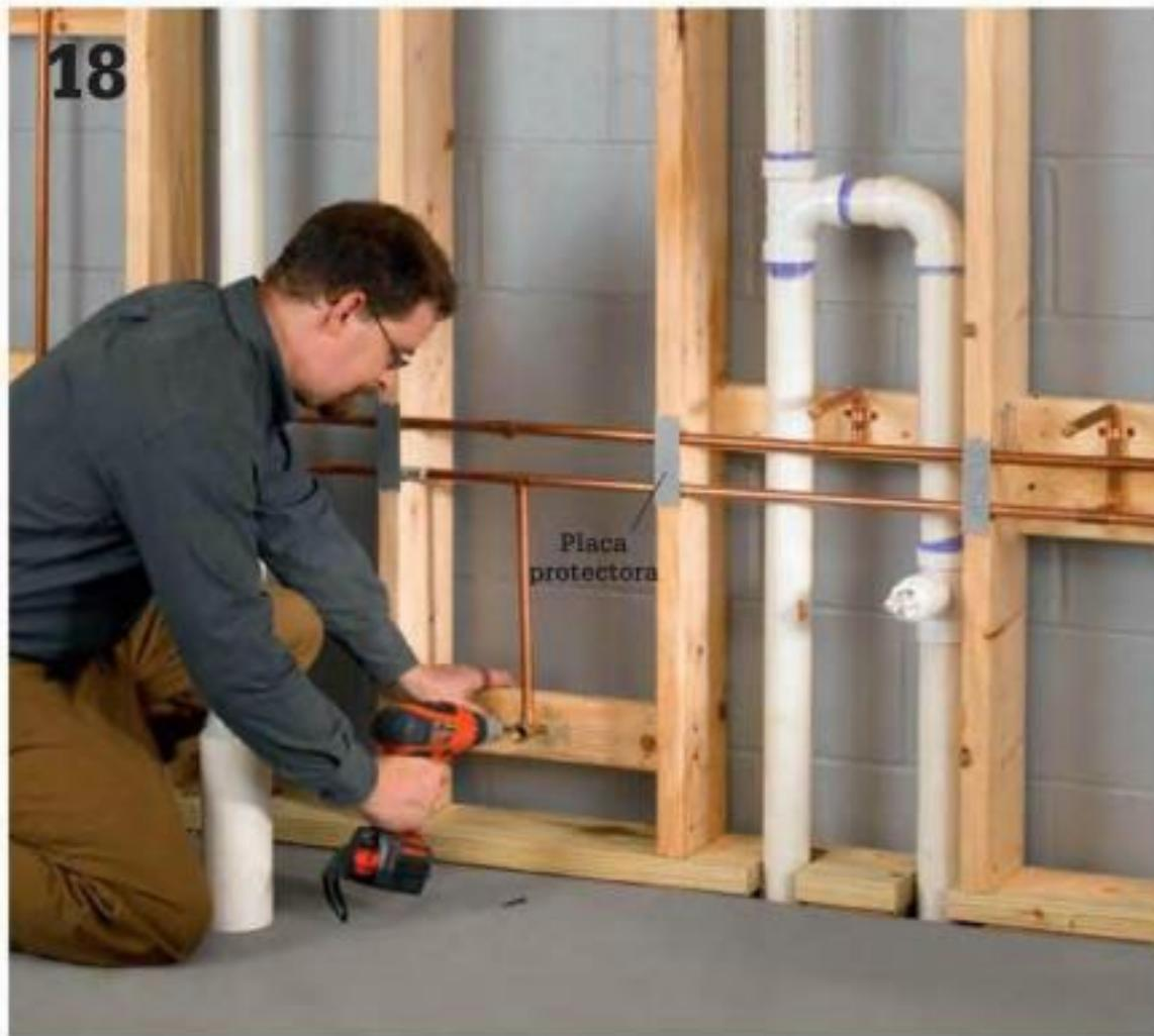
**Instale la plomería de suministro de agua,** que parecerá muy fácil en comparación de la plomería de desagüe y respiración. Siga las instrucciones en la página 169, pero modifique la disposición para que se ajuste a sus instalaciones.
