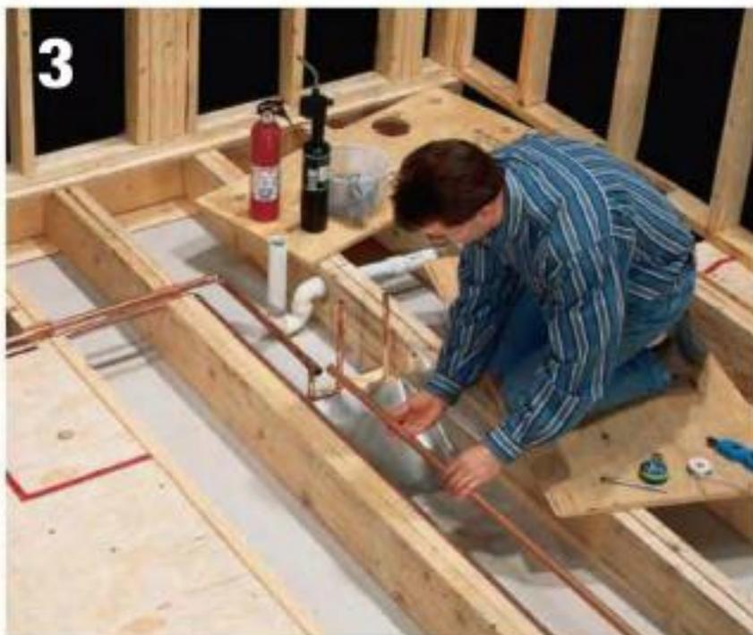
**Extienda la tubería** de agua hasta la bañera y la ducha. En este proyecto, quitamos el sub-piso y mellamos las vigas para pasar tubería de suministro de  $\frac{3}{4}$ " desde el lavamanos hasta la bañera whirlpool, luego hasta la ducha. En la bañera, usamos uniones T reductoras y codos para crear tubos ascendentes de  $\frac{1}{2}$ " para el grifo. Suelde tapones sobre los tubos ascendentes; después de instalar el sub-piso, los tapones se remueven y reemplazan con válvulas de retención.
