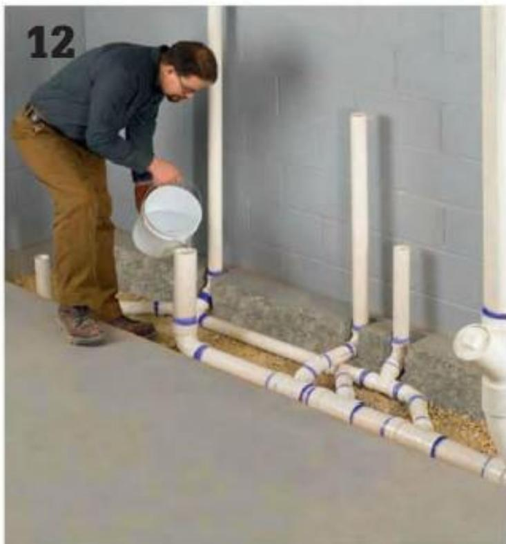
**Revise si hay fugas echando agua** en cada tubería nueva de desagüe. Si las uniones parecen estar bien, póngase en contacto con el departamento de construcción y programe la inspección (debe hacerlo antes de cubrir la tubería). Tape las aberturas con trapos para evitar que salga gas cloacal. *Nota: algunos municipios también piden una prueba de aire.*
