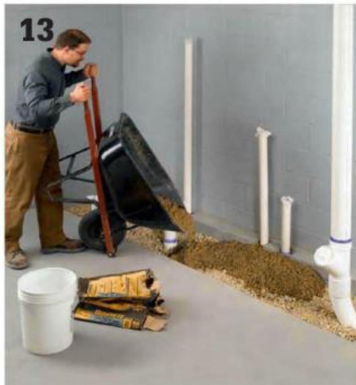
**Rellene alrededor de las tuberías** con la tierra extraída de la zanja; mezcle y eche concreto nuevo para cubrir la zanja, y allane con la paleta. Deje que el concreto fragüe durante 3 días. Algunos municipios exigen que una membrana de aislamiento sea envuelta en los tubos verticales donde estarán rodeados de concreto; investigue con el inspector local.
