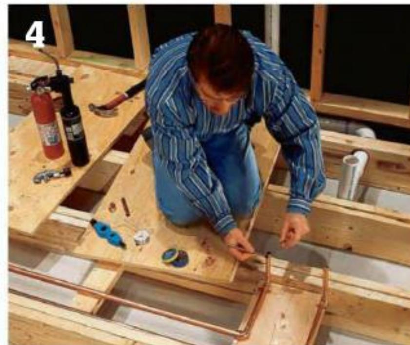
**En la localización de la ducha**, use codos para crear tubos ascendentes donde será construida la pared húmeda de la ducha. Los tubos ascendentes deben extenderse por lo menos 6" por encima del piso. Apóyelos con una tabla de soporte de  $\frac{3}{4}$ " pegada entre vigas; suelde los tapones sobre ellos. Después de construir el compartimento para la ducha, los tapones son removidos y reemplazados con válvulas de retención.
